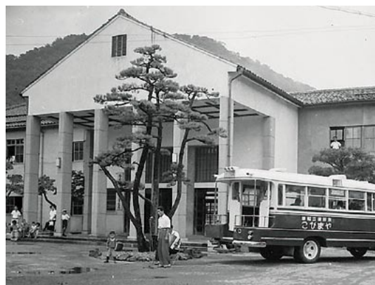
昭和19年建築の庁舎（3代目）
